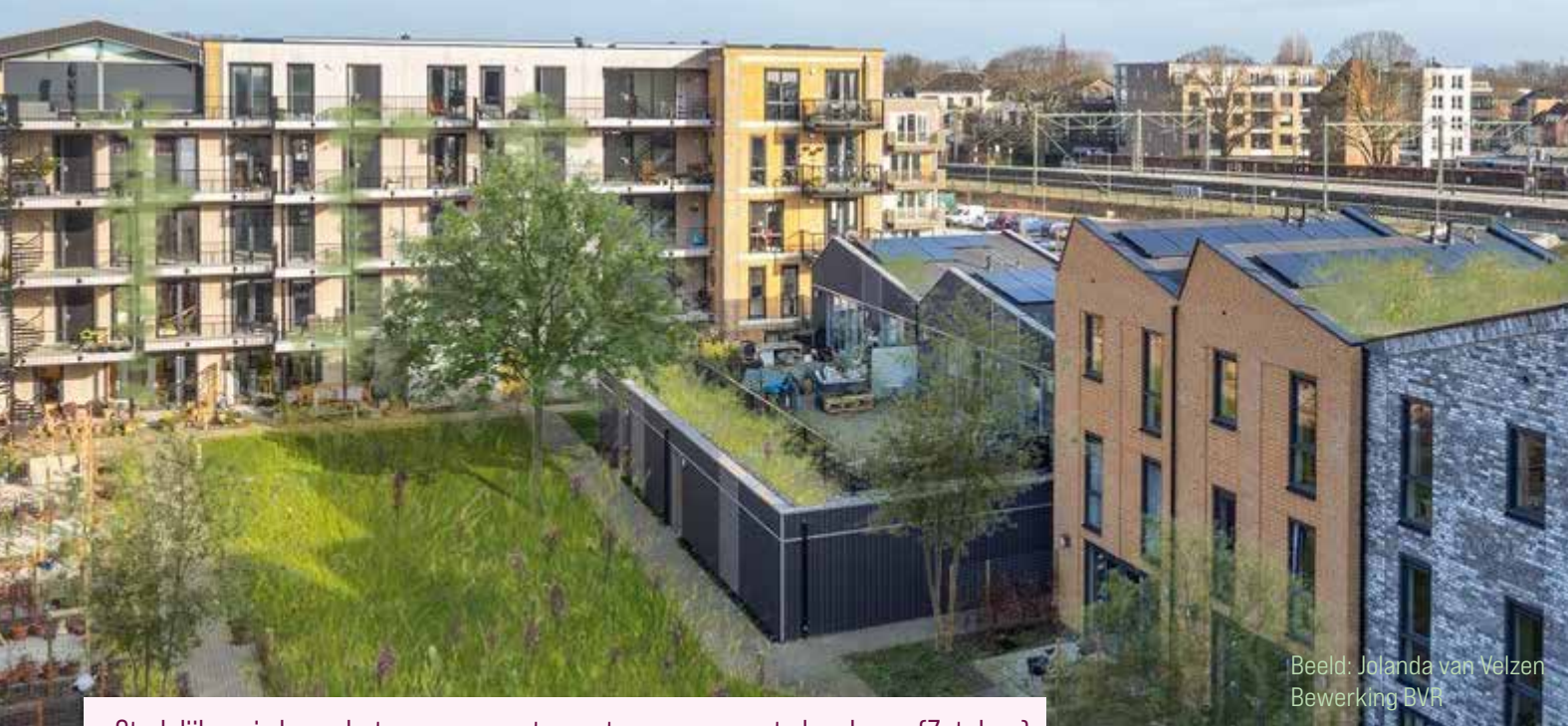
Stedelijke mix langs het spoor: appartementen en compacte laagbouw (Zutphen)
