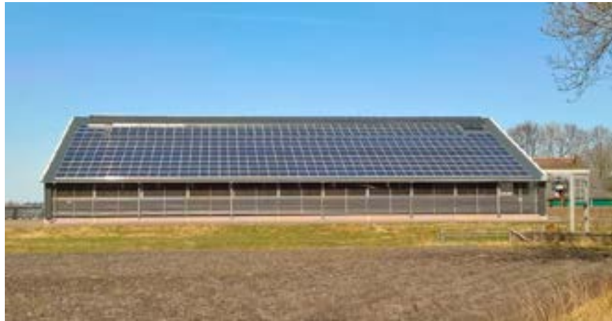
Zonnepanelen op agrarische bedrijfsbebouwing aan de Kanaaldijk
