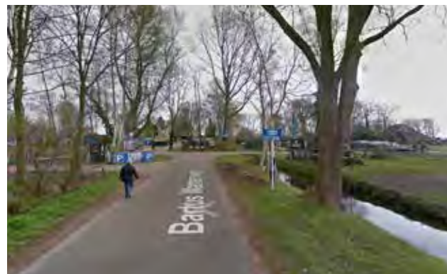
Beschermd Dorpsgezicht aan de zuidkant van het centrum: de kenmerkende samenhang met het landschap is hier aangetast.
