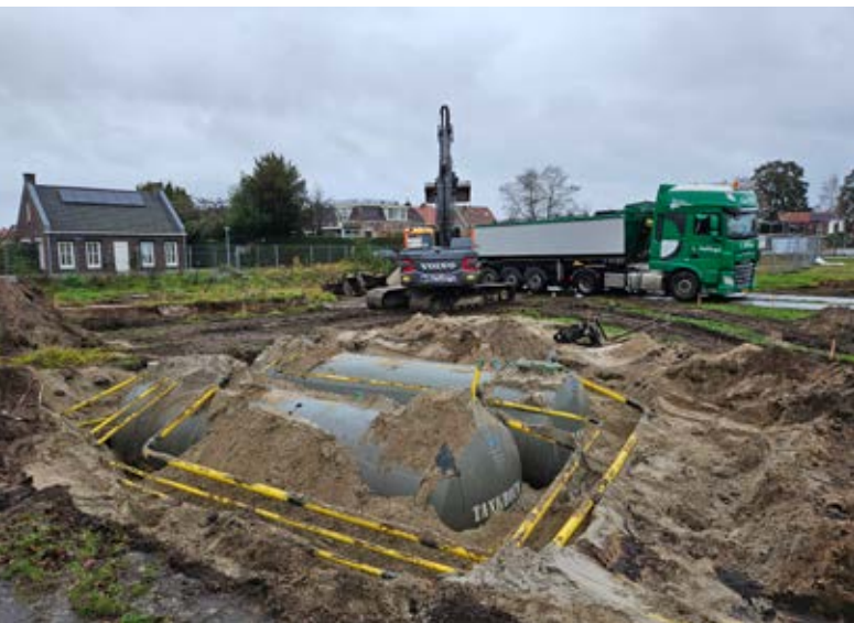
▲ Grondsanering op de voormalige Rijkmanslocatie.
