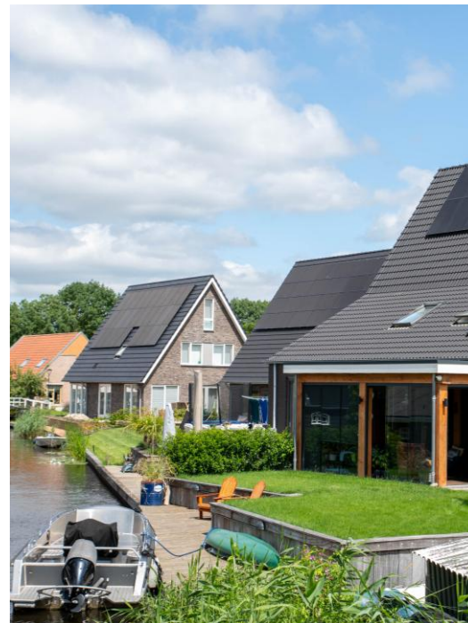
▲ Nieuwbouw Rietveld in Belt-Schutsloot. Foto: gemeente Steenwijkerland.
