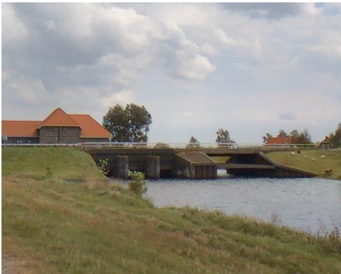
Foto: huidige brug bij Stoinkemaal
