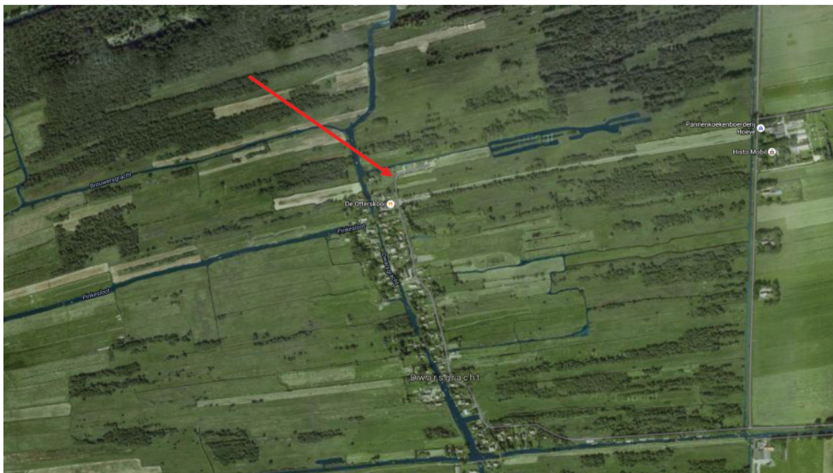
Figuur 1: luchtfoto projectlocatie en de directe omgeving
